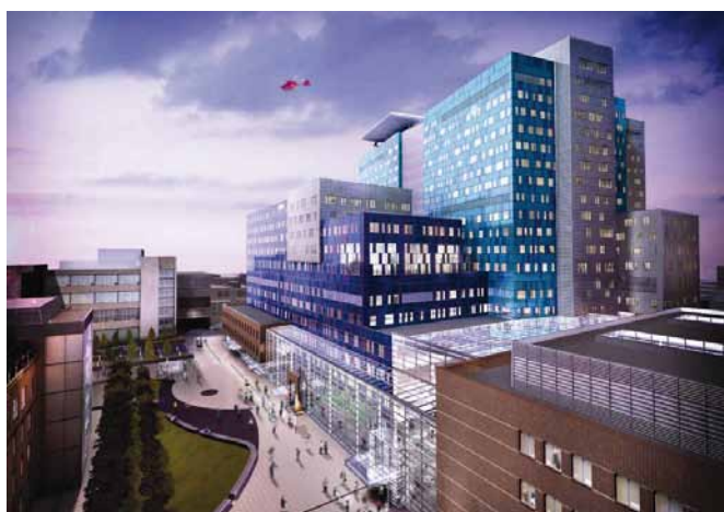
Nach Fertigstellung aller Bauabschnitte wird das Barts Hospital das größte Krankenhaus ganz Großbritanniens sein.
