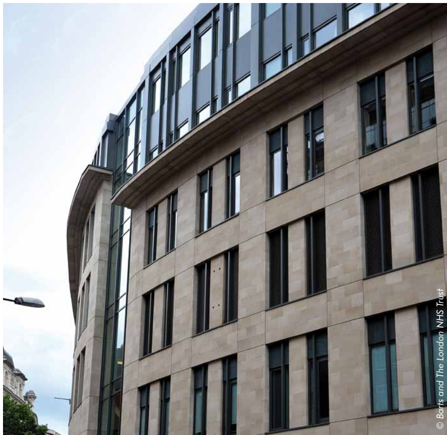
Bei den Sonnenschutzelementen des ersten Bauabschnitts sorgt die Kombination von animeo Motorsteuerungsgeräten mit einer intelligenten Sensorik für angenehme Lichtverhältnisse und Energieeffizienz.
