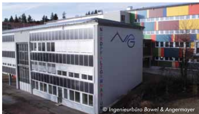
Nordpfalzgymnasium in Kirchheimbolanden
